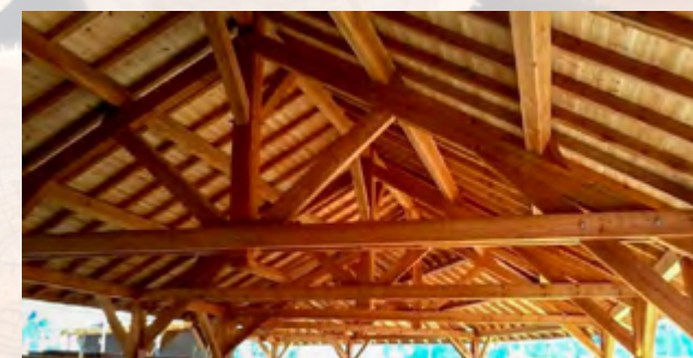
Charpente en mélèze au Rousset (photo Bonnefont)
